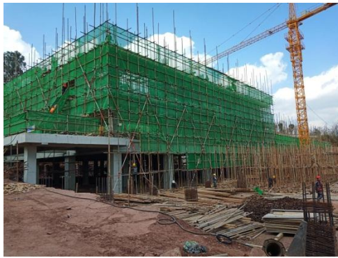
报告厅施工进展情况
