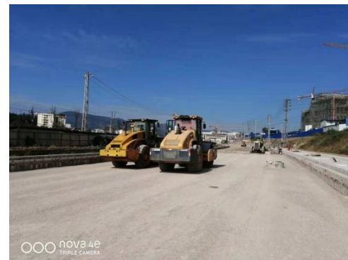
水稳料摊铺、碾压
