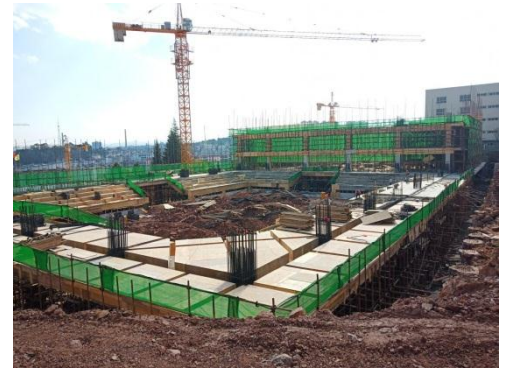
音体馆施工进展情况
