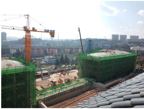
2 # 教学楼、3 # 教学楼施工进展情况
