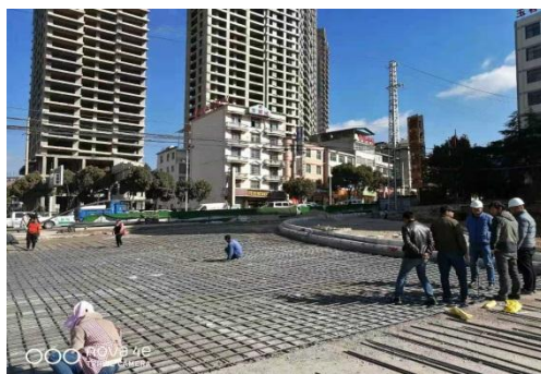
狮山大道平交口新老路搭接钢筋砼路面钢筋绑扎（双层）
