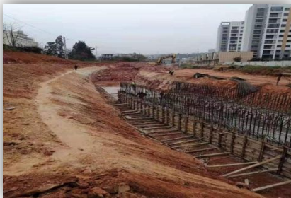
排洪沟测量放线
