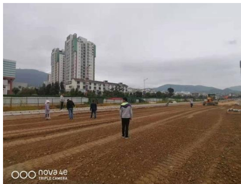
级配料摊铺、碾压、标高控制
