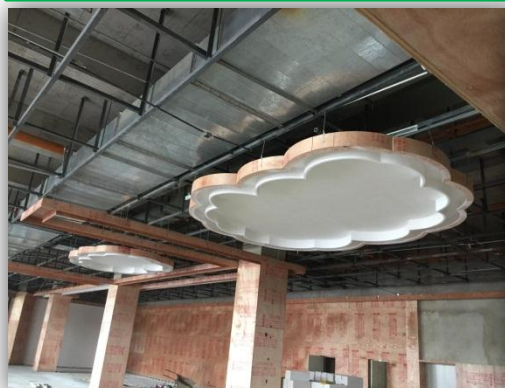
图书馆施工实况照片
