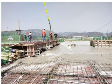
综合业务楼主体封顶
