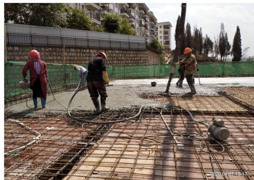
食堂主体封顶
