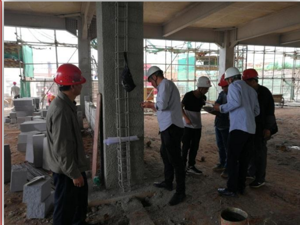
防火涂层厚度检测
