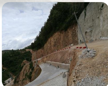
大坝右岸新建永久道路边防撞墩完成
