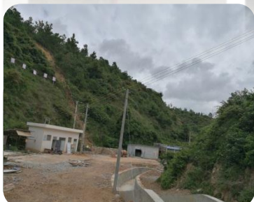
管理房、启闭室输电线路架设完毕
