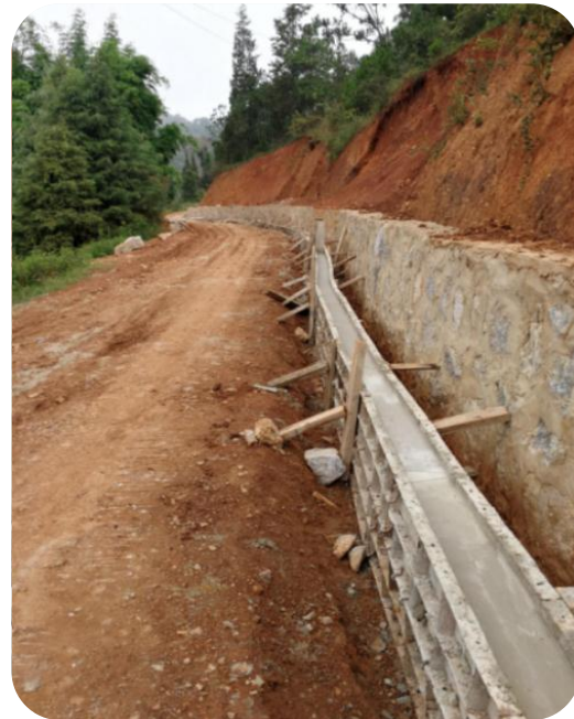
进场道路 C20 混凝土沟
