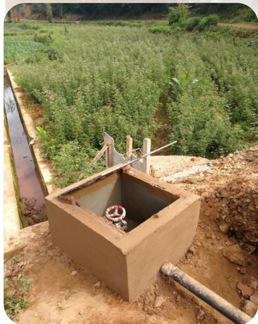
输水管道 DN80 支管安装
