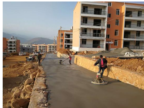
道路砼浇筑中
