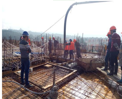
混凝土浇筑旁站
