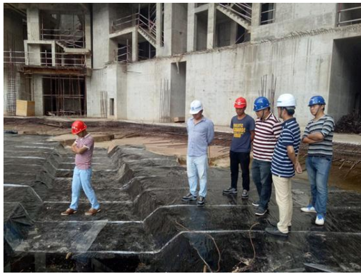
地下室防水验收
