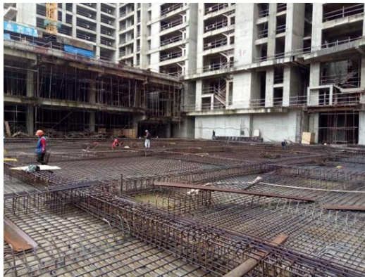
筏板梁钢筋绑扎
