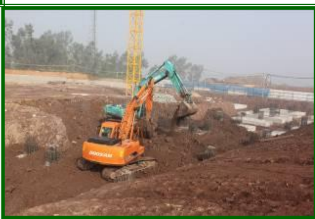
中学综合教学楼土方开挖回填
