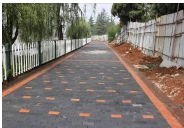
透水砖道路铺设
