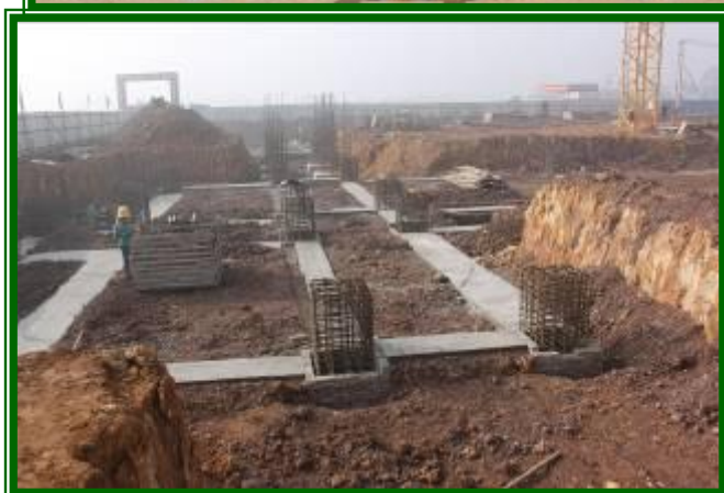
小学综合教学楼独立承台
