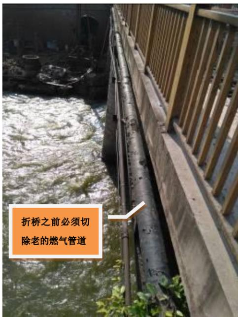
折桥之前必须切除老的燃气管道
